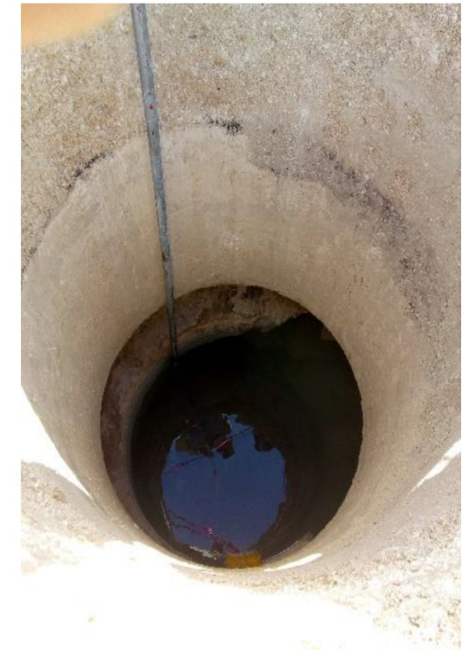
Perforación previa para el hincado de pilotes
