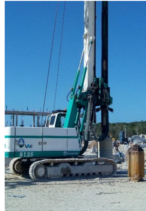
Perforación previa para el hincado de pilotes
